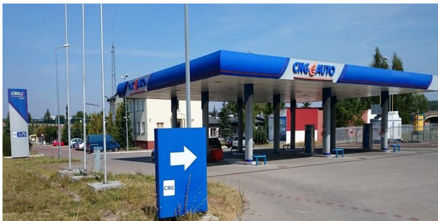
Rysunek 27 Stacja tankowania sprężonego gazu ziemnego
