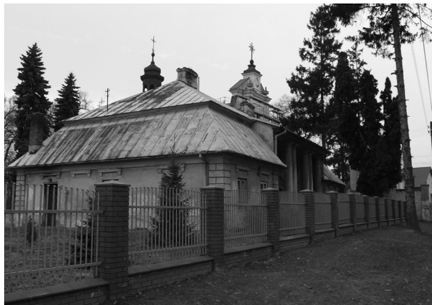
PLEBANIA PRZED I PO PRACACH RESTAURATORSKICH, WIDOK OD STRONY POŁUDNIOWO-WSCHODNIEJ, FOT. D. KOPCIOWSKI.
