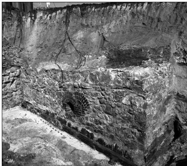
FOT. 2. WIDOK NA UMIEJSCOWIENIE PRZYCZÓŁKA WSCH. PRZEJAZDU KOLEJOWEGO NA UL. KUNICKIEGO (FOT. M. DOBRZYŃSKI)
