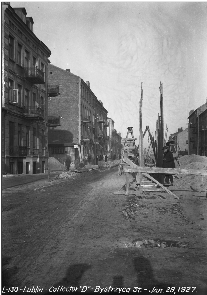
L-130 - Lublin - Collector "D" - Bystrzyca St. - Jan. 29, 1927. ULICA KUNICKIEGO W TRAKCIE BUDOWY WODOCIĄGU W 1927 ROKU, FOT. ZE ZBIORÓW MPWIK.
