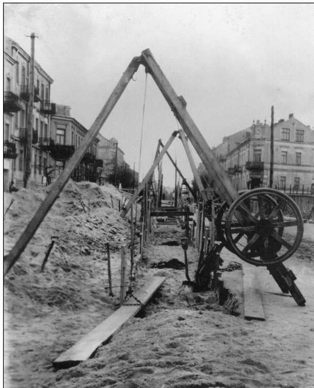
BUDOWA WODOCIĄGU NA UL. KUNICKIEGO, 1926, FOT. ZE ZBIORÓW MPWIK
