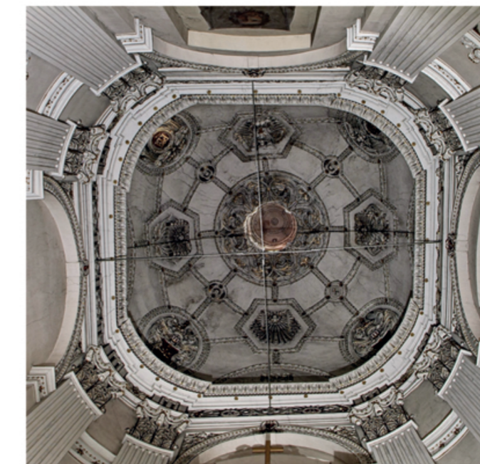
Gewölbe der Firlej-Kapelle
