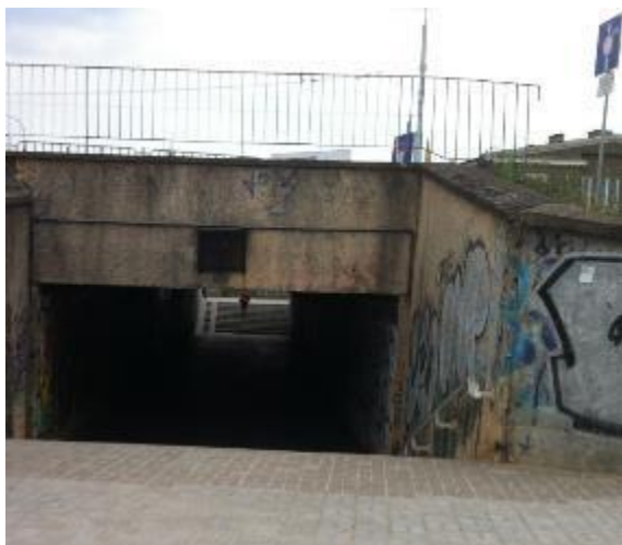
Fot. o.16. Przykład niskiej jakości przejścia podziemnego na skrzyżowaniu al. Tysiąclecia i ul. Hutniczej. (zdj. TransEko).
