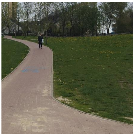
Fot. o.26. Park Jana Pawła II. Infrastruktura rowerowa jest bardziej atrakcyjna niż chodnik. (zdj. TransEko).
