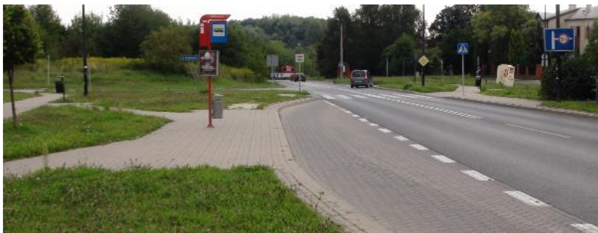
Fot. o.18 Przystanek autobusowy bez dojścia pieszego od strony przejścia dla pieszych. (zdj. TransEko).
