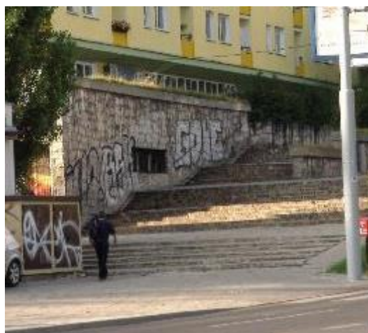
Fot. o.20 Ul. Lwowska – brak pochylni przy schodach (zdj. TransEko).
