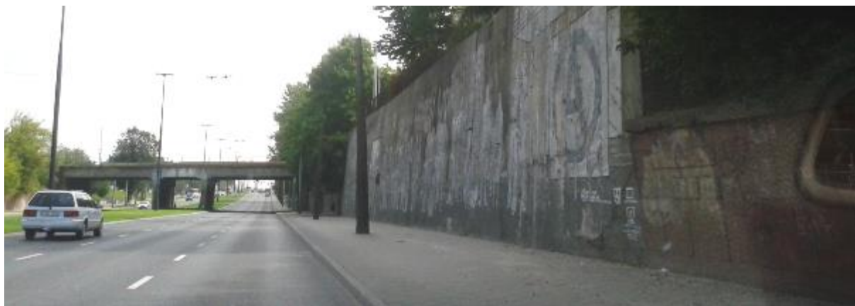
Fot. o.10. Przykład szerokiego pasa drogowego ul. Mełgiewskiej, w rejonie wiaduktu kolejowego (zdjęcie: TransEko).
