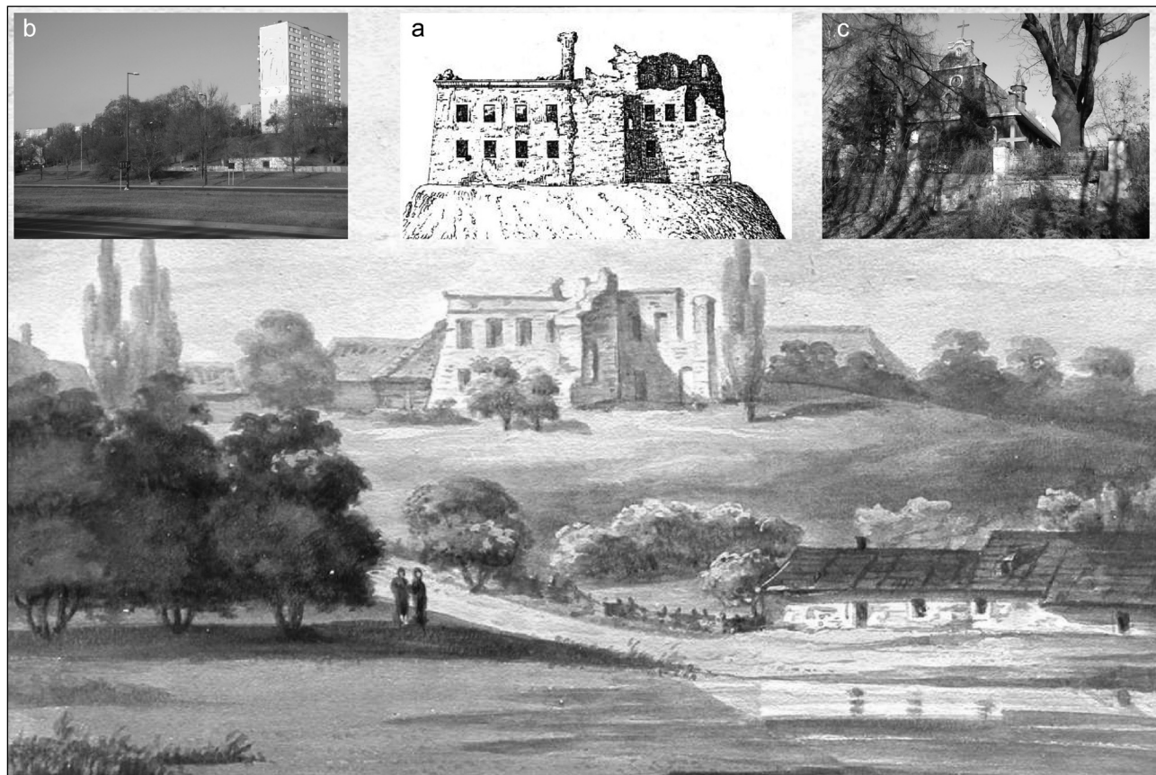
IL. 4. RUINY ZAMKU NA CZECHOWIE – AKWARELA ADAMA LERUE W ATLASIE KAZIMIERZA STRONCZYŃSKIEGO (1852-1853 R.); OPR. D. BEDNARSKI, J. TKACZYK. A – SZKIC SEWERYNA SIERPIŃSKIEGO Z 1839 R.; B – WIDOK WSPÓŁCZESNY OD STRONY UL. SOLIDARNOŚCI; C – KOŚCIÓŁ MARIAWITÓW PW. MATKI BOSKIEJ NIEUSTAJĄCEJ POMOCY Z 1906 R.
