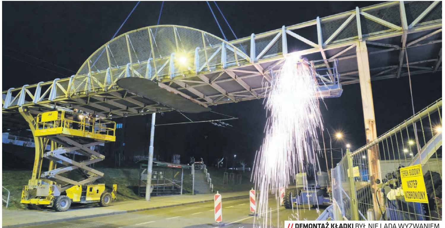
// DEMONTAŻ KŁADKI BYŁ NIE LADA WYZWANIEM
