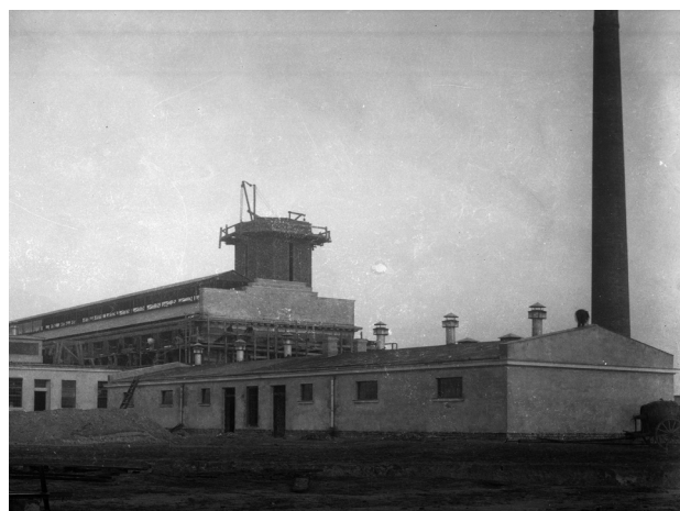
BUDOWA RZEŹNI NA TATARACH, 1929, FOT. ZE ZBIORÓW MPWIK W LUBLINIE.
