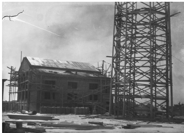
BUDOWA ELEKTROWNI NA KOŚMINKU, 1927 ROK, FOT. ZE ZBIORÓW MPWIK.
