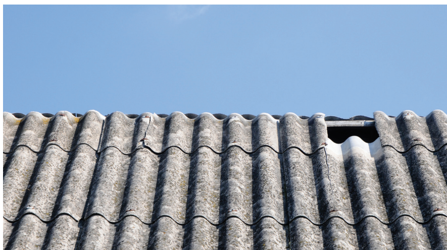
Płyty azbestowo-cementowe tzw. eternit
