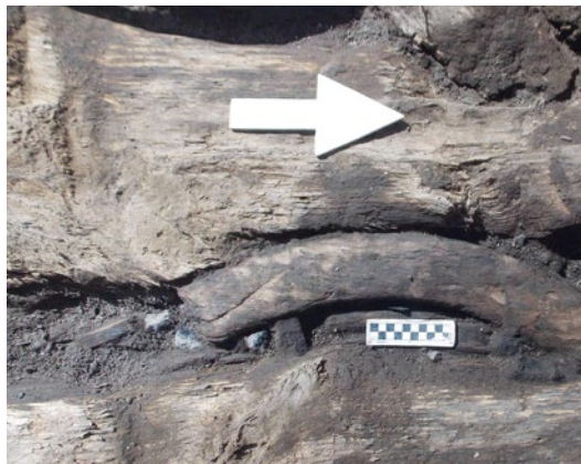
Widok na fragment koła od wozu wpasowany w szczelinę pomiędzy kłodami młodszej nawierzchni (fot. P. Zimny)
