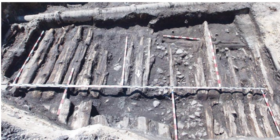
Liczne pozostałości uzupełniania kamieniami ubytków w starszej nawierzchni z bali drewnianych (fot. P. Zimny)
