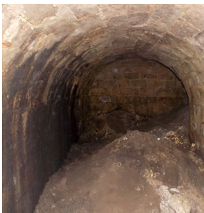
Wnętrze szczeliny przeciwlotniczej na placu Litewskim (fot. P. Zimny) Interior of the anti-aircraft slots at the Lithuanian Square
