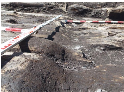
Koleiny wrzynające się w starszą nawierzchnię z bali drewnianych przy Hotelu Europa (fot. P. Zimny) Ruts cut in the surface of wooden beam road at Hotel Europa
