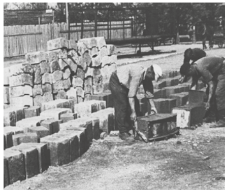
Produkcja bloczków przez ludność cywilną (fot. ze zbiorów UM Lublin) Production of building blocks by civilians
