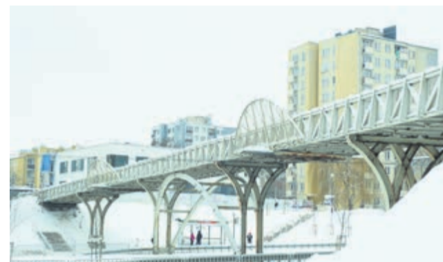
// KŁADKA NAD UL. FILARETÓW PRZEJDZIE PRZEBUDOWĘ
