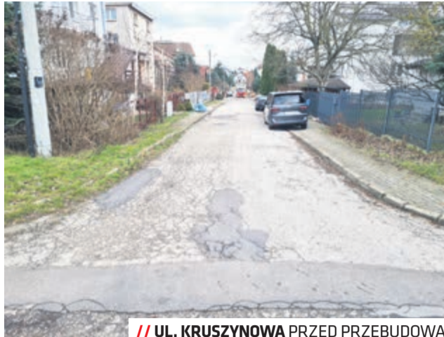
// UL. KRUSZYKOWA PRZED PRZEBUDOWĄ
