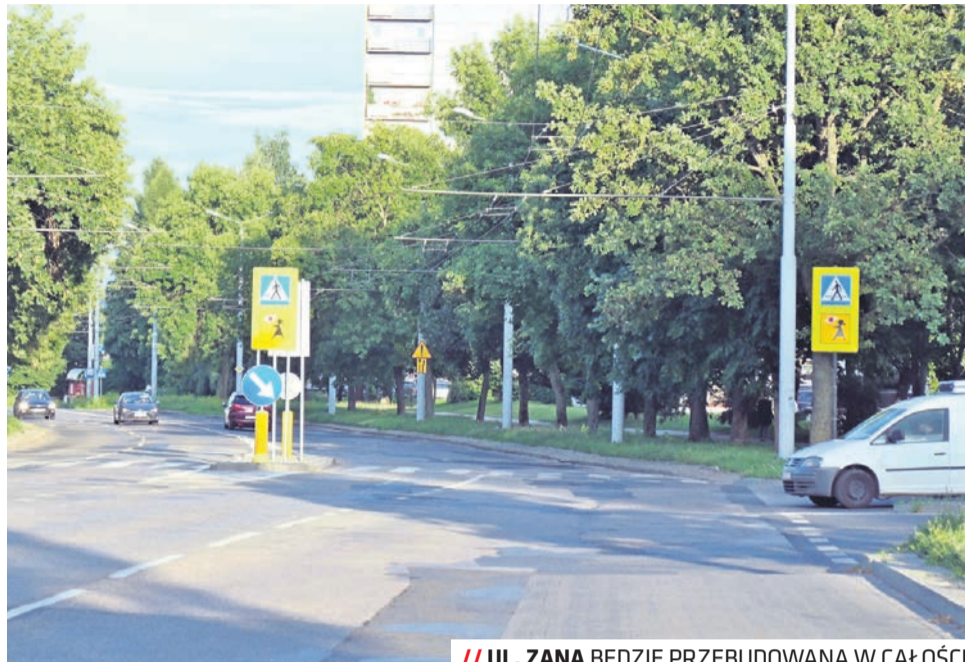
// UL. ZANA BĘDZIE PRZEBUDOWANA W CAŁOŚCI
