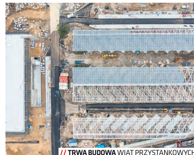
// TRWA BUDOWA WIAT PRZYSTANKOWYCH
