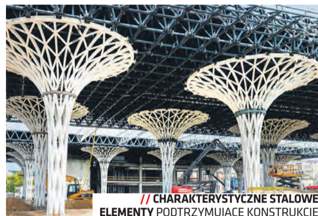
// CHARAKTERYSTYCZNE STALOWE ELEMENTY PODTRZYMUJĄCE KONSTRUKCJĘ
