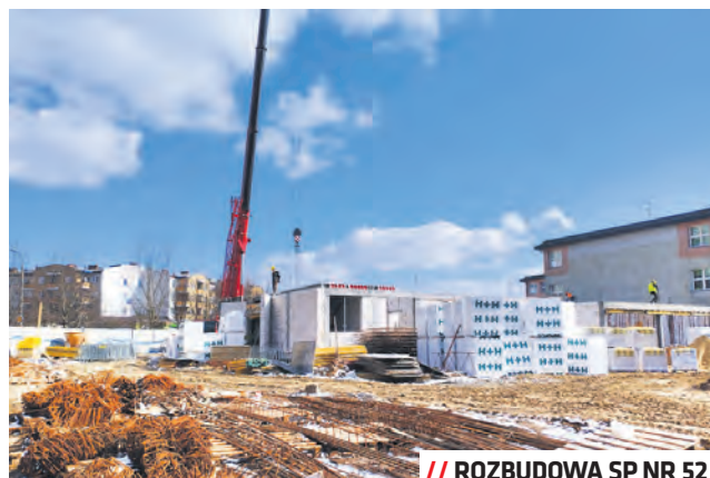
// ROZBUDOWA SP NR 52
