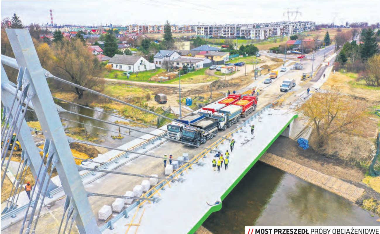
// MOST PRZESZEDŁ PRÓBY OBCIĄŻENIOWE
