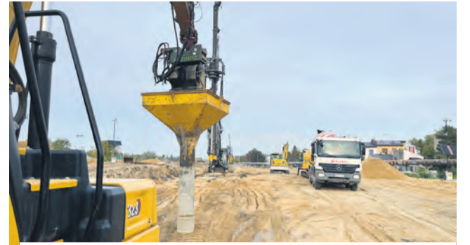
// PRACE PRZY PRZEDŁUŻENIU UL. LUBELSKIEGO LIPCA '80
