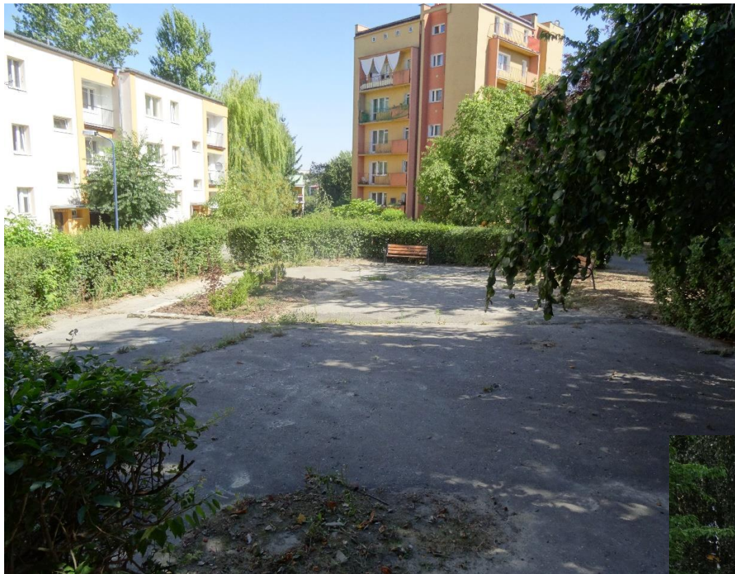
ul. Skautów- skwer w trakcie realizacji
