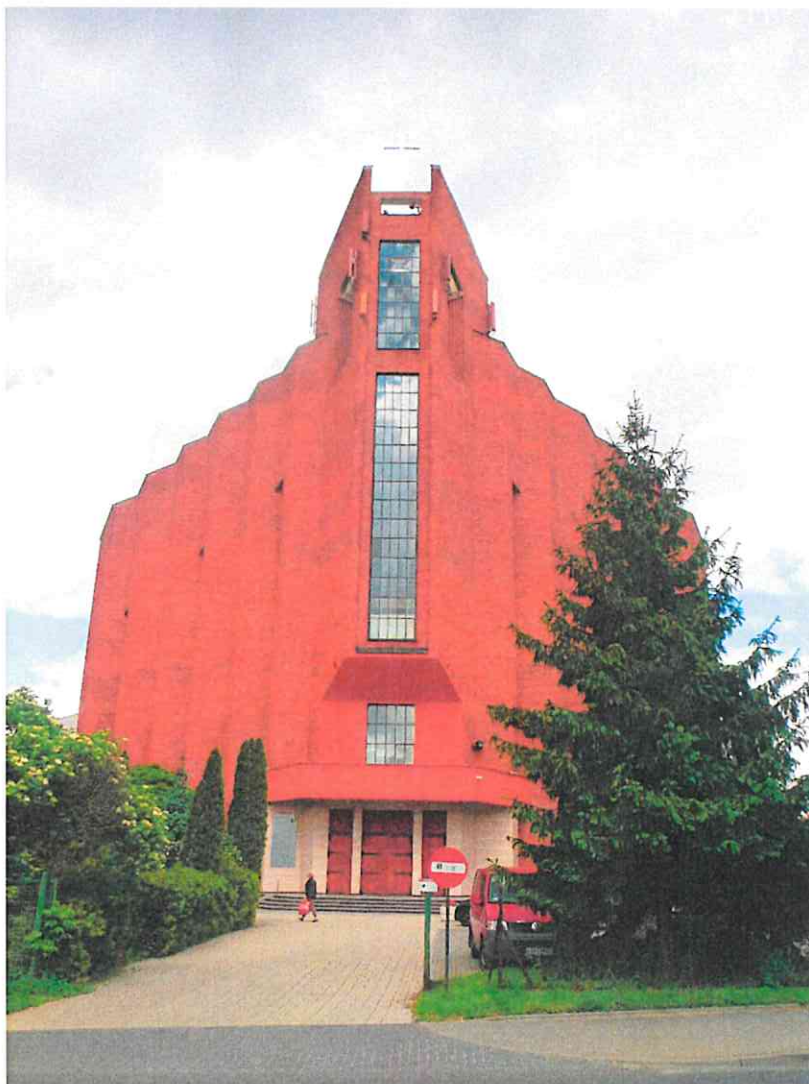
Zdjęcie 1 Badany obiekt
