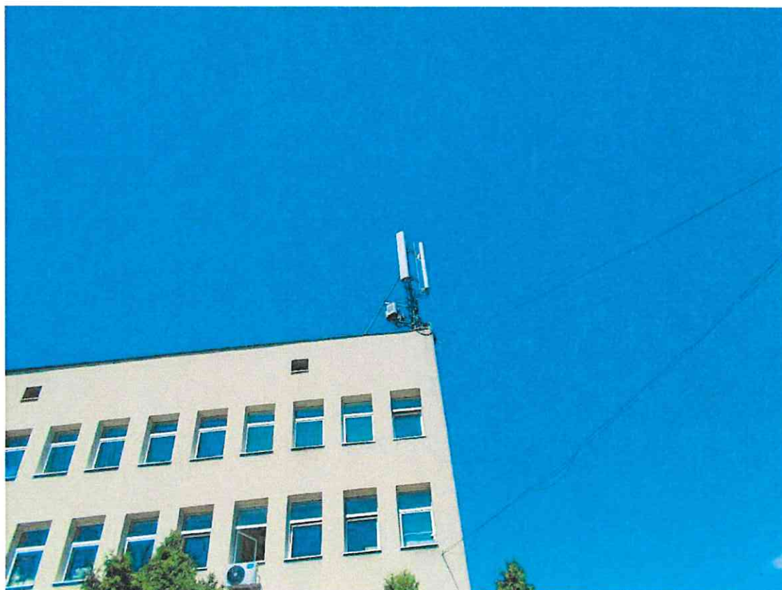
Zdjęcie 1 Badany obiekt
