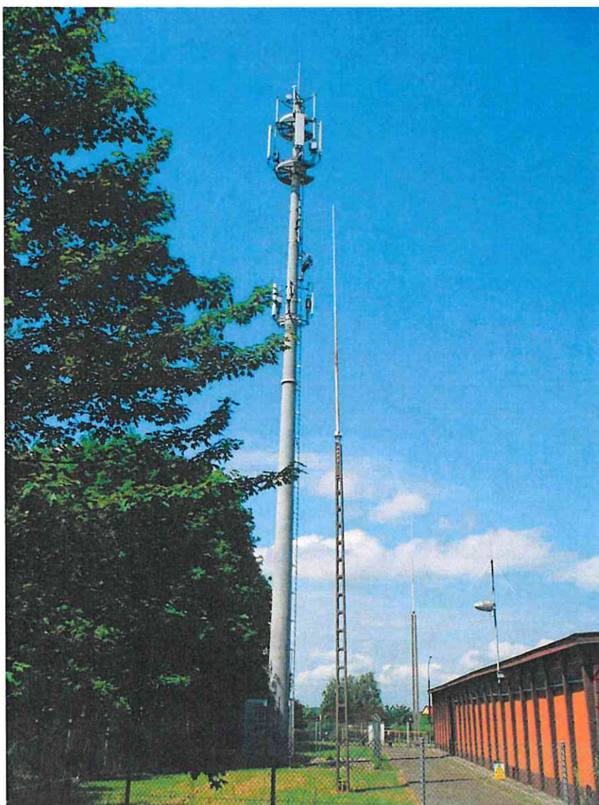
Zdjęcie 1 Badany obiekt
