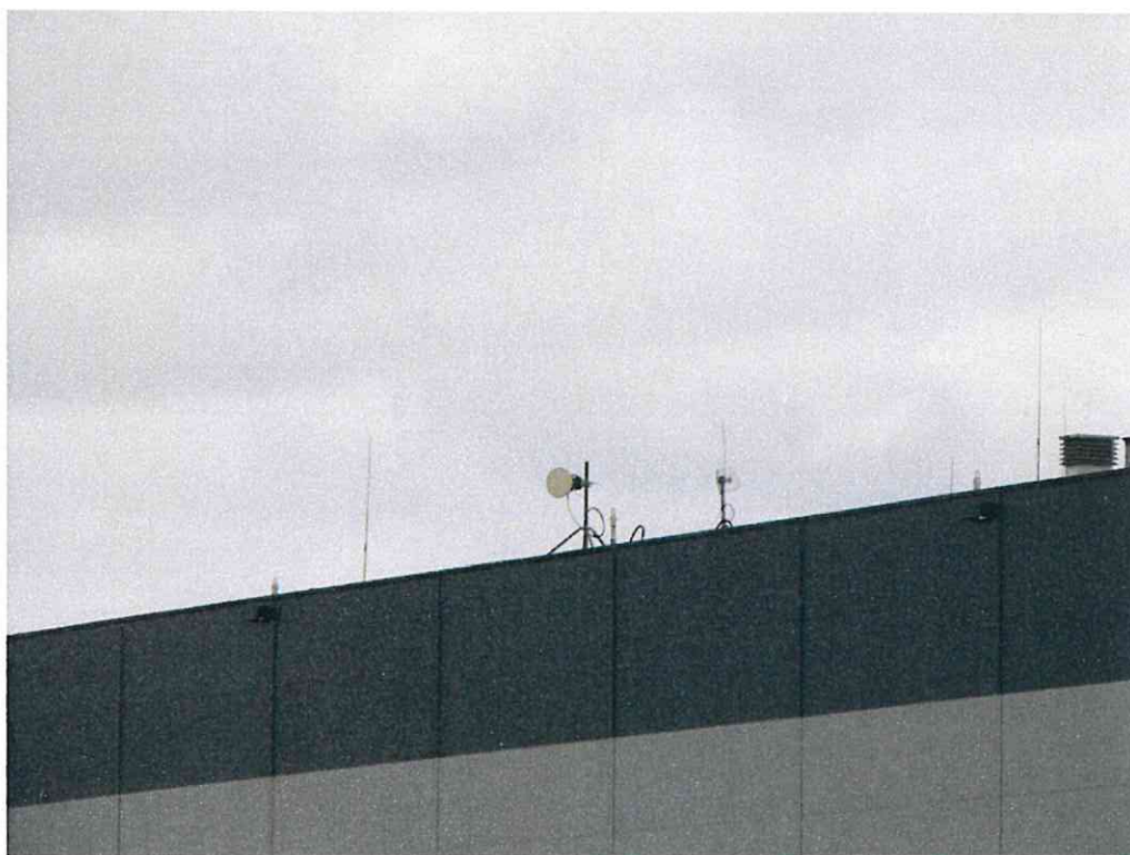
Widok instalacji radiokomunikacyjnej Stacja Netia LUBLB831 - LUBLM00296ANT001 Lublin, ul. Józefa Franczaka „Lalka” 18.
