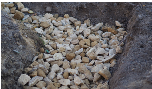
Wykop w trakcie wypełniania kruszywem | Fot. Fundacja Sendzimira;
