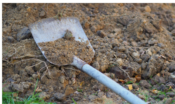
Wykonywanie wykopu | Fot. Fundacja Sendzimira;
