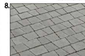
Nawierzchni z kostki brukowej
