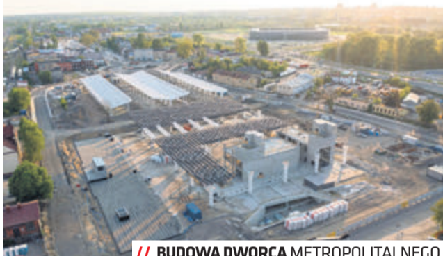
// BUDOWA DWORCA METROPOLITALNEGO
