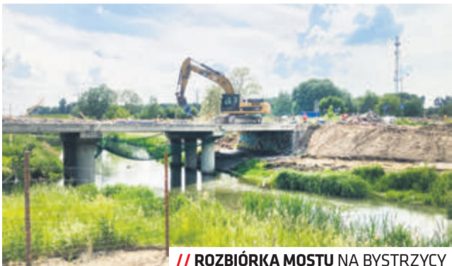
// ROZBIÓRKA MOSTU NA BYSTRZYCY
