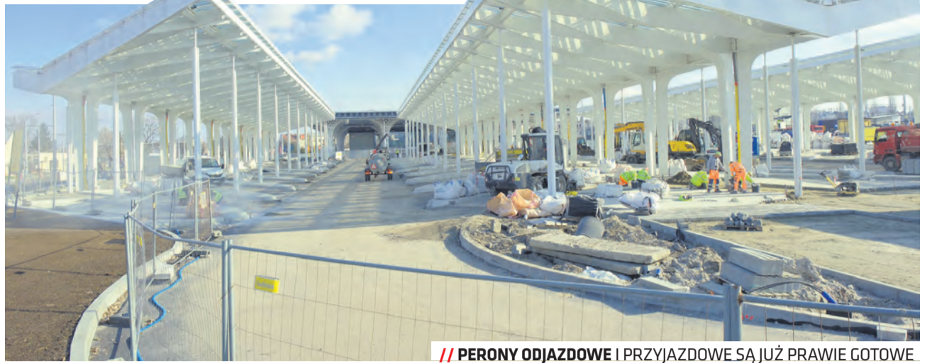
// PERONY ODJAZDOWE I PRZYJAZDOWE SĄ JUŻ PRAWIE GOTOWE
