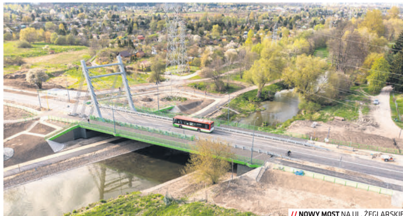
// NOWY MOST NA UL. ŻEGLARSKIEJ
