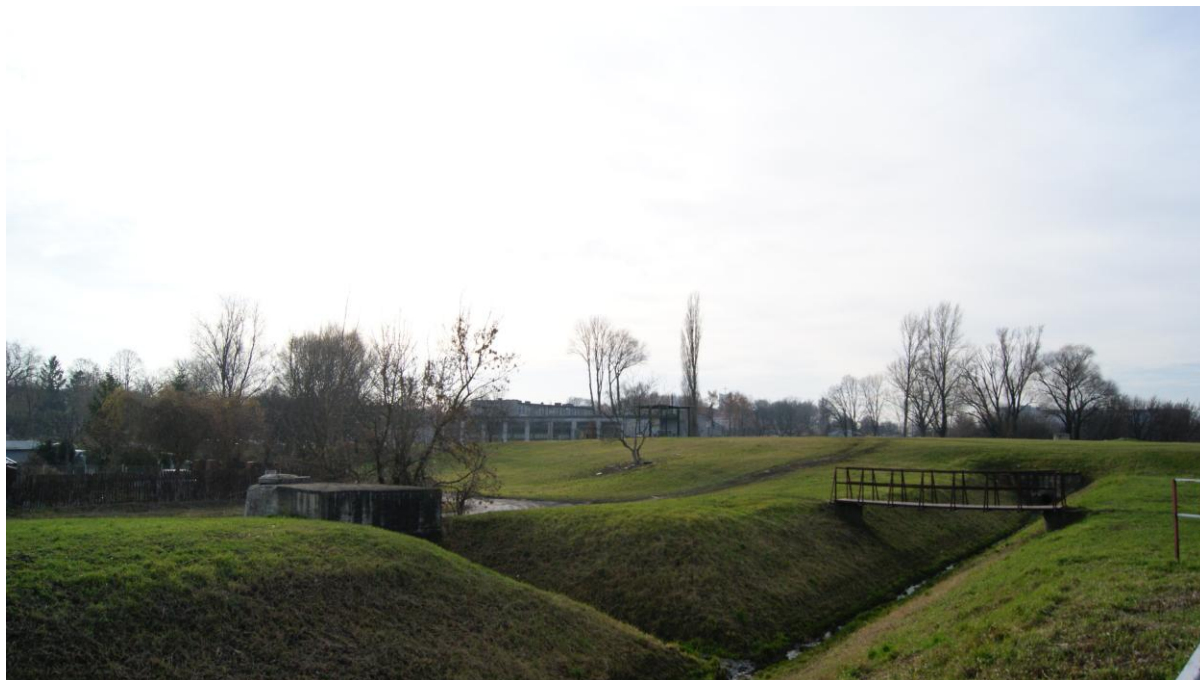
Widok na rów odprowadzający wody deszczowe do Bystrzycy; Archiwum ABA
