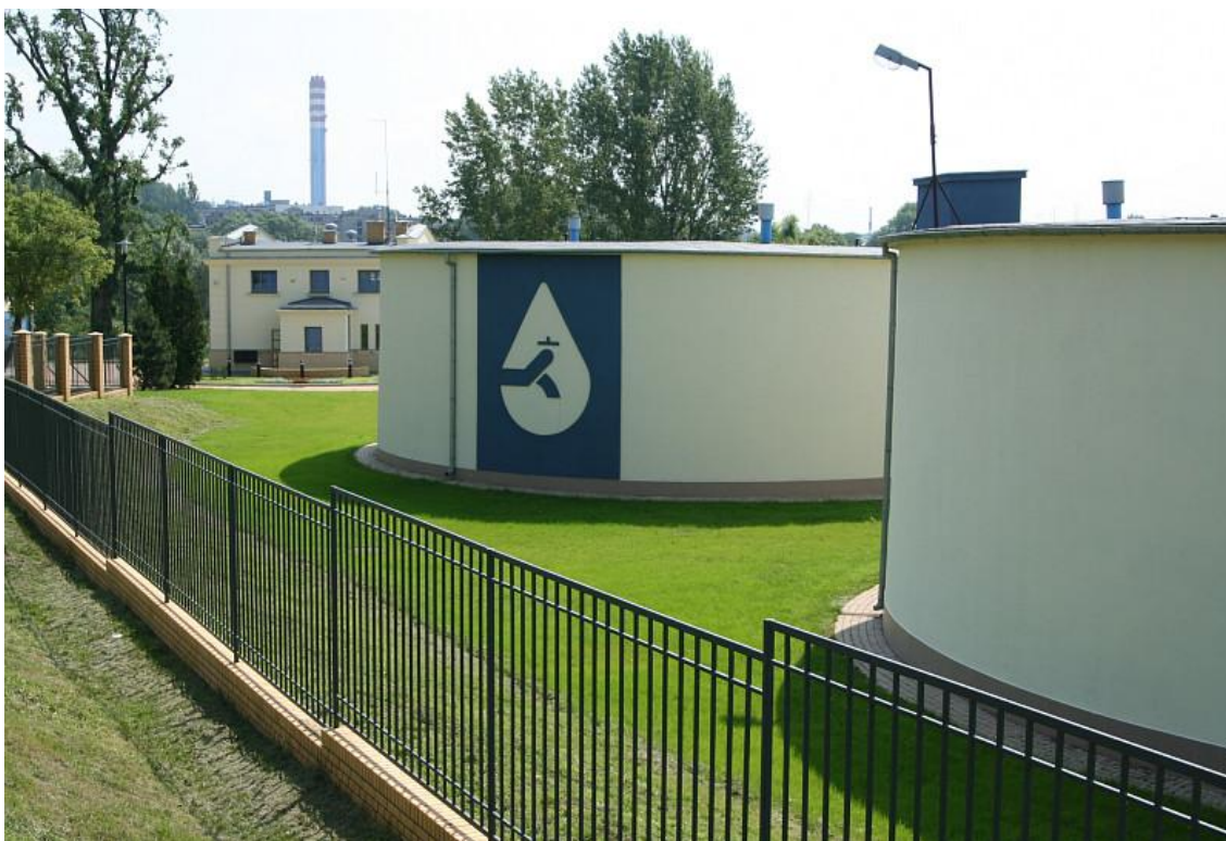
Stacja wodociągowa Lublin Wrotków
