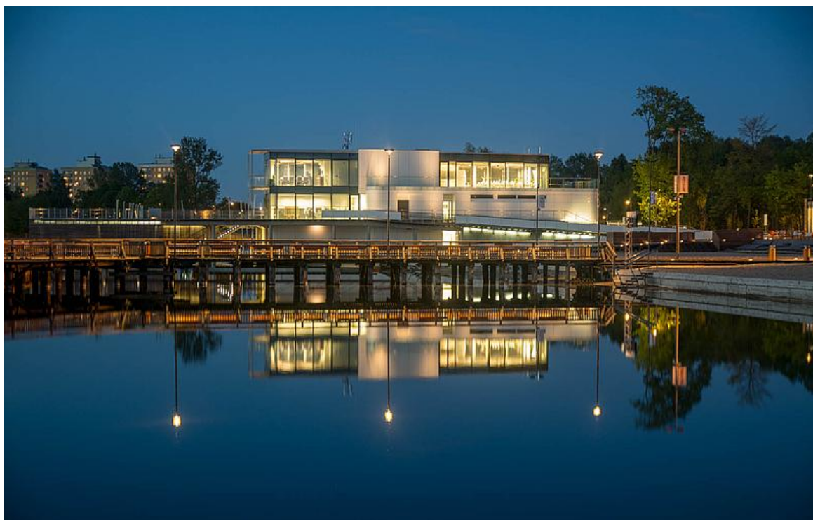
Całoroczne Centrum Sportowo - Rekreacyjne nad jeziorem Ukiel;
