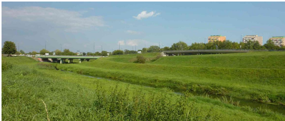
Mosty komunikacyjne - wschodnia granica terenu lokalizacji; Archiwum ABA
