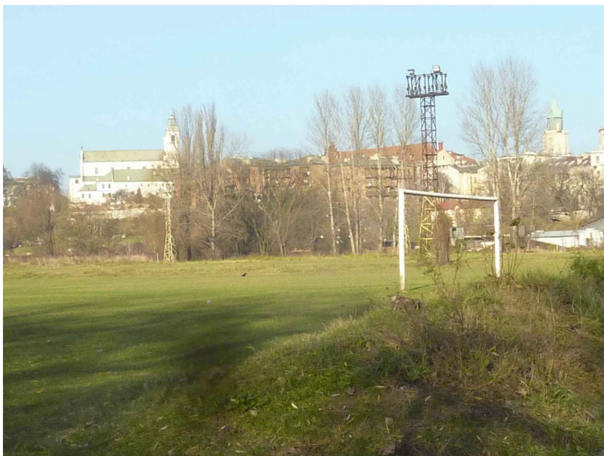
Widok otaczającej zabudowy z istniejącego boiska (archiwum ABA)
